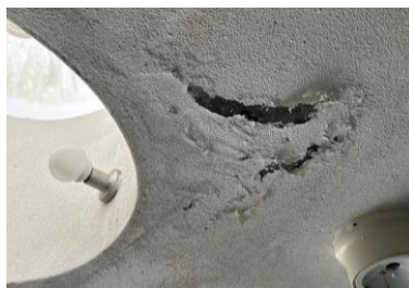
▲天井 塗装の剥がれ、一部雨漏り有
